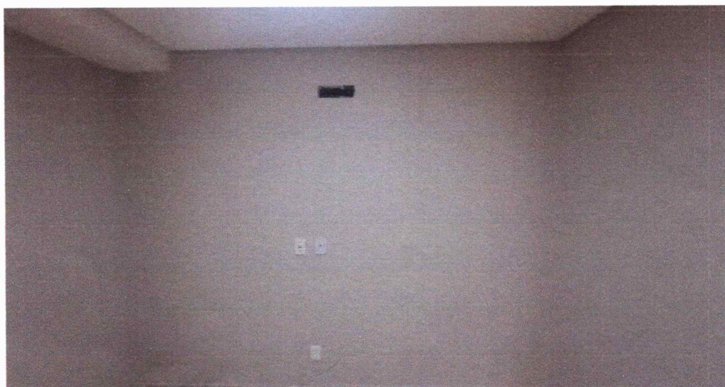
Figura 4 – Instalação de pontos de internet e telefone.
