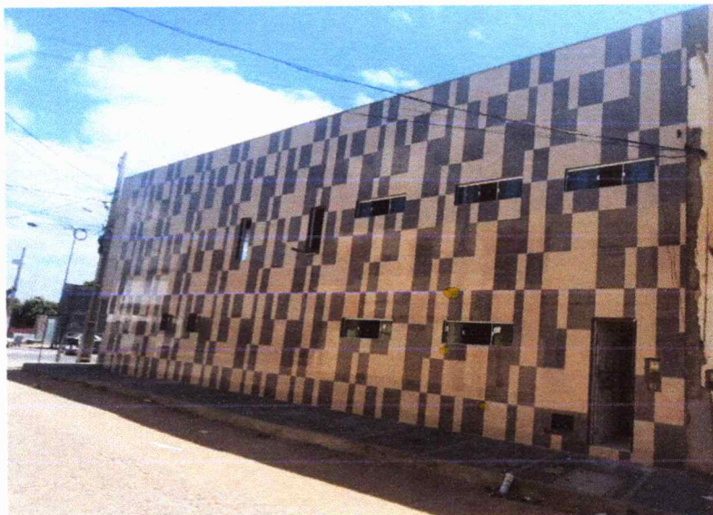
Figura 2 – Instalação de revestimento cerâmico, porcelanato.
