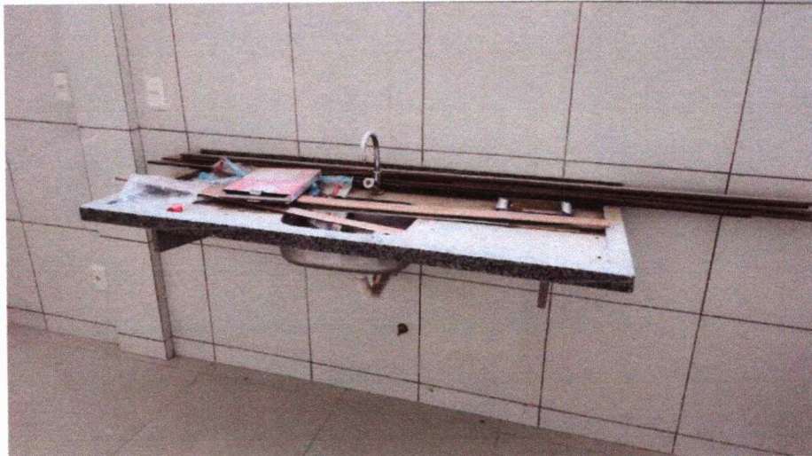
Figura 8 – Instalação de bancadas de granito
