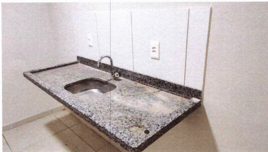
Figura 9 – Instalação de bancadas de granito.
