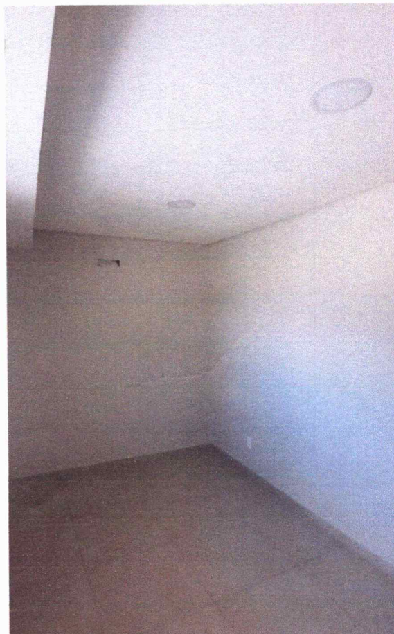
Figura 10 – Instalação de luminária plafon de led embutida.
